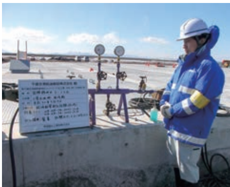
消防法に基づく燃料配管耐圧検査の様子
