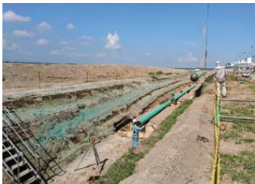
駐機場部における地下燃料配管の埋設作業
