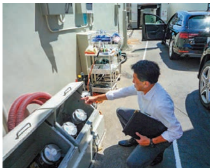
注油口の点検
