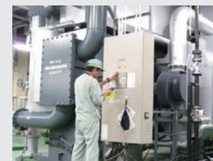
空調設備の点検の様子
