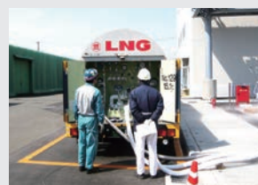
LNG受け入れ作業
