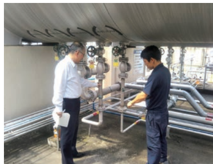
ガス配管設備の確認
