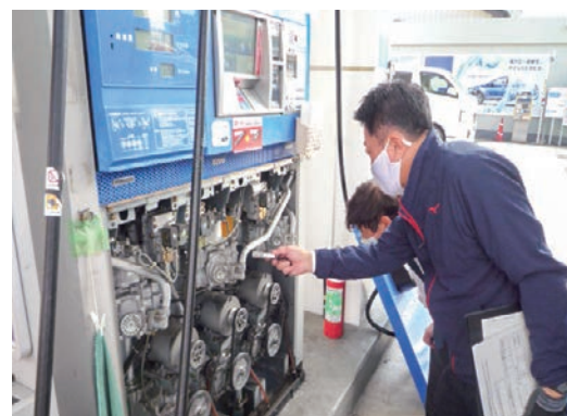
サービスステーションの現場確認
