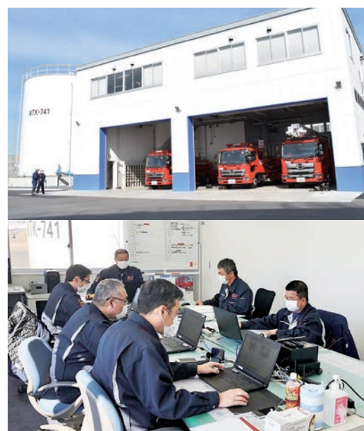
防災センター
