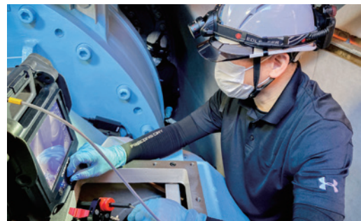
内視鏡を使用した機器内部の調査
