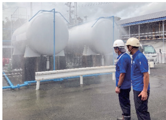
散水による鎮火作業
