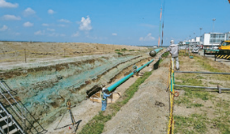
駐機場部における地下燃料配管の埋設作業
