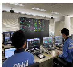
コントロールルーム での監視業務
