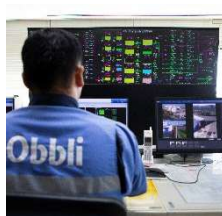
コントロールルーム での監視業務
