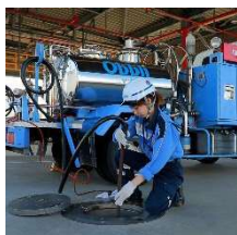
給油設備の 点検業務
