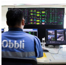
コントロールルーム での監視業務
