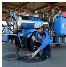
給油設備の 点検業務
